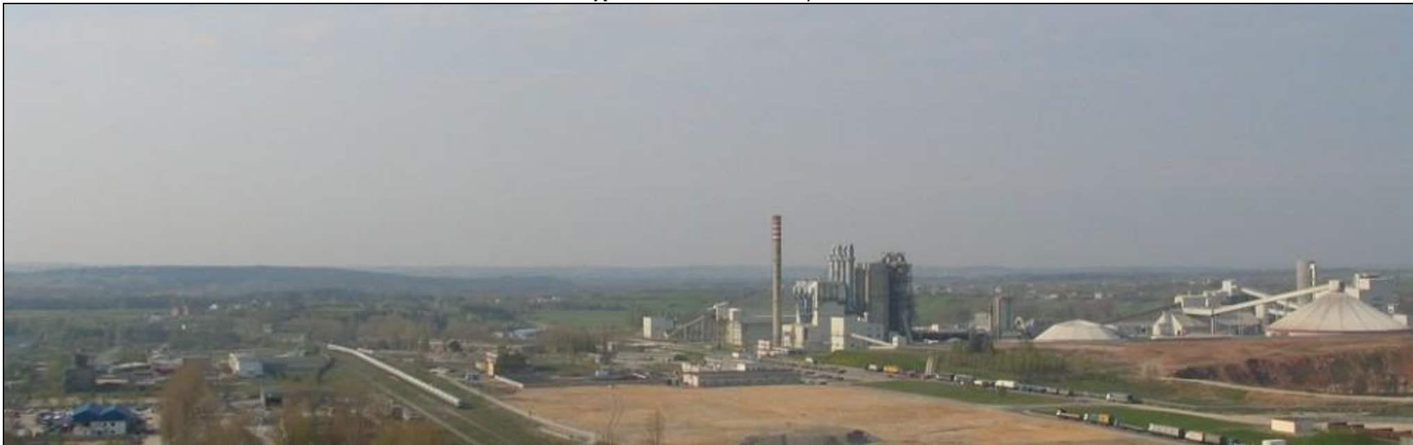
Zdjęcie 5 Cementownia Nowiny
